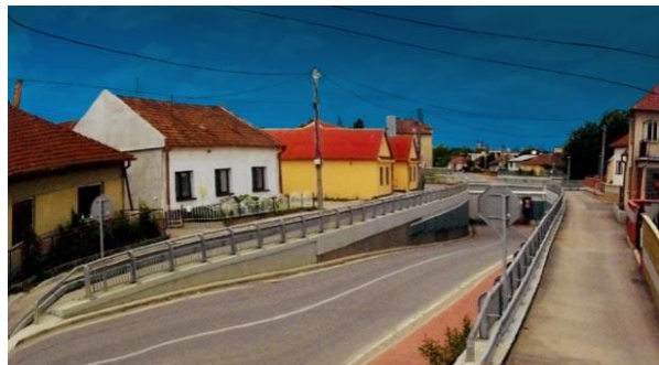
Obrázok 42 Podjazd pod železničnú trať
